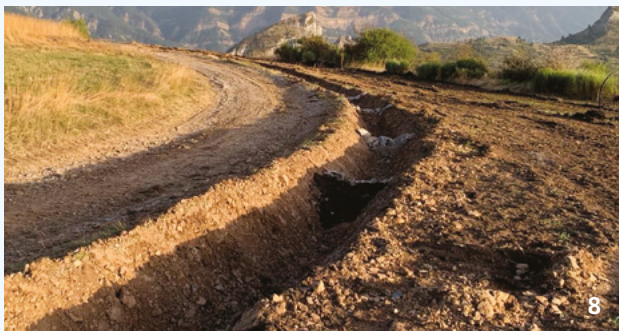
Vue d'un fossé à redents
