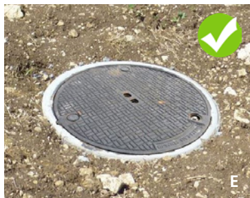
Fig. 3 (A) Coperchio difettoso di un pozzetto senza funzione di drenaggio (fonte: Cant. TG); (B) Coperchio aperto di un pozzetto di drenaggio senza fascia tampone (fonte: Cant. SO); (C) Coperchio intatto, ma con bordatura difettosa permeabile all'acqua (fonte: AWEL Cant. ZH); (D) Coperchio di aerazione a livello del suolo senza fascia tampone (fonte: AWEL Cant. ZH); (E) Coperchio chiuso con foro di prelievo (fonte: Cant. SO); (F) Coperchio in calcestruzzo completamente carrabile (fonte: cant. TG).
