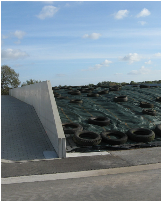
Le choix de l'emplacement, la conception et le dimensionnement du silo sont déterminants pour une utilisation optimale de l'installation. Les voies d'accès pour les véhicules, les travaux de bâchage ainsi que l'utilisation de dispositifs de désilage en font également partie (photo de gauche : Fübbeker ; à droite système de Silo GB)
