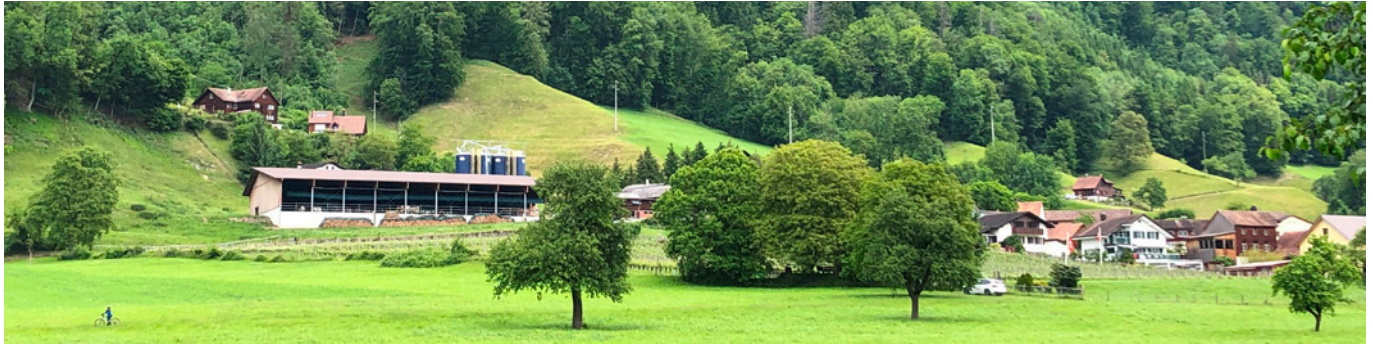
Les installations de silos devraient s'intégrer au mieux dans le paysage et le bâti (photo : AGRIDEA).
