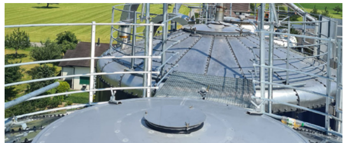
Neben Geländern und Absturzsicherungen bei der Einfüllöffnung erhöhen auf den Hochsilos ausreichend breite sowie rutschfeste Verbindungsstege die Sicherheit beim Arbeiten (Bild: GB Silo System)
