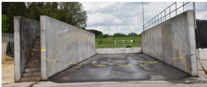
Sturzunfälle lassen sich bei Fahrsilos mit Geländern und/oder Brüstungen vermeiden. Mit einem Gang von mind. 1 m Breite zwischen zwei Silos wird ein sicherer Zugang für Abdeckarbeiten geschaffen (Bild: AGRIDEA)
