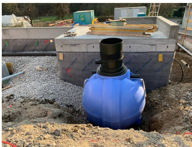
Un serbatoio di raccolta sotterraneo deve essere a doppia parete e resistente al gelo, Ripalga AG.
