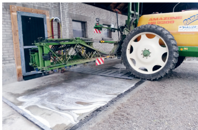
La barra di irrorazione non sporge oltre la piazza di lavaggio e tutta l'acqua viene convogliata nel serbatoio di ritenzione attraverso la griglia di drenaggio, Th. Haller.
