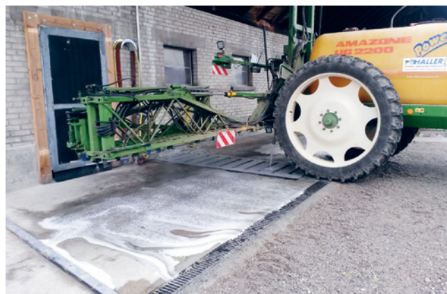
La barre de traitement ne dépasse pas l'aire de nettoyage et toute l'eau de rinçage atteint la cuve de rétention par la grille de drainage, Th. Haller.
