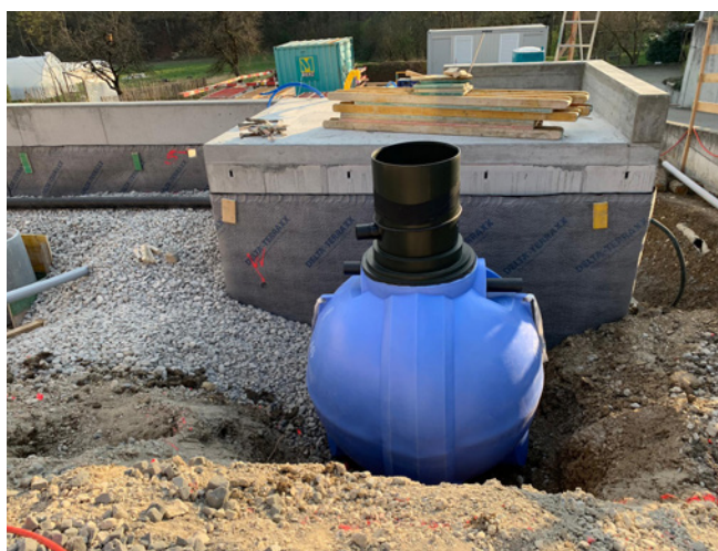
Un tank de stockage souterrain doit être à double paroi et résistant au gel, Ripalga AG.
