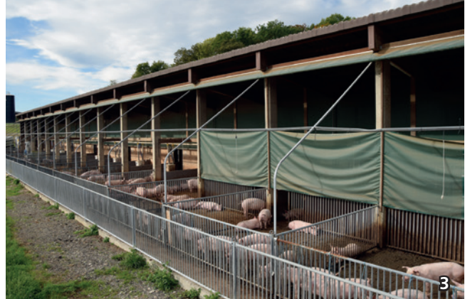
2004 gebauter Schweinestall, 560 MSP (Mastschweineplätze) mit offener Tiermasthalle, BTS- und RAUS-kompatibel.
