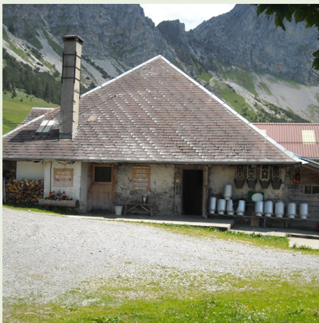
Alp Jänzimatt, Herrenhütte, Obwalden
