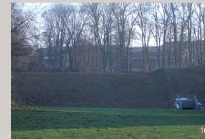
**Hochwasserentlastungskorridore:** Beim Überschreiten der Abflusskapazität wird das überlaufende Wasser gezielt aus dem Gerinne ausgeleitet und durch einen Korridor mit niedrigem Schadenspotenzial abgeleitet, ohne grosse Schäden im Siedlungsgebiet anzurichten. Findet eine Überflutung der Landwirtschaftsflächen statt, können die Bewirtschafter entschädigt werden. Die Nutzungsaufgaben von Überschwemmungsgebieten unterscheiden sich zwischen den Kantonen.
