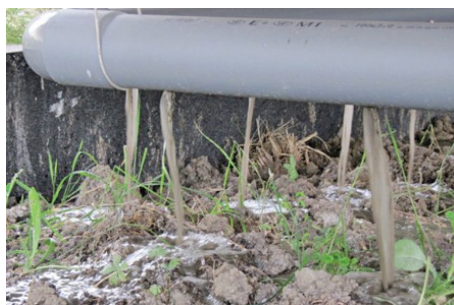
Figura 17: distribuzione dell'acqua inquinata tramite tubi forati (AGRIDEA)
