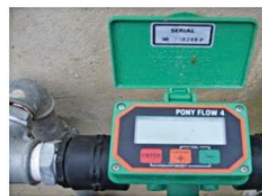
Figura 4: contatore volumetrico elettronico (G. Fiaux, 2007)
