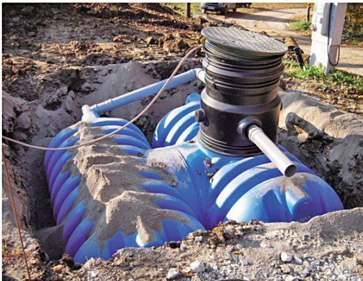
Figura 7: cisterna interrata a doppio strato (L. Chevalier)
