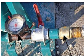
Figura 3: contatore volumetrico meccanico con valvola antiritorno (G. Fiaux, 2007).
