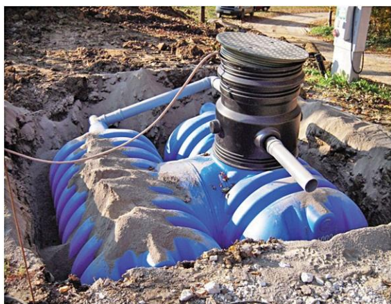
Foto 7: Unterirdischer Tank mit Doppelwand (L. Chevalier)
