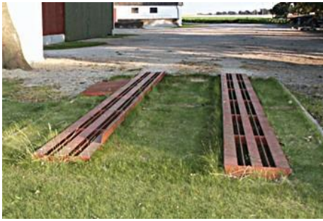
Foto 10: System für die Unterstützung der Rampen (M. Castillo)
