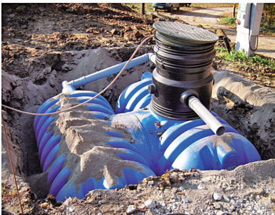
Photo 7: cuve enterrée avec double manteau (L. Chevalier).
