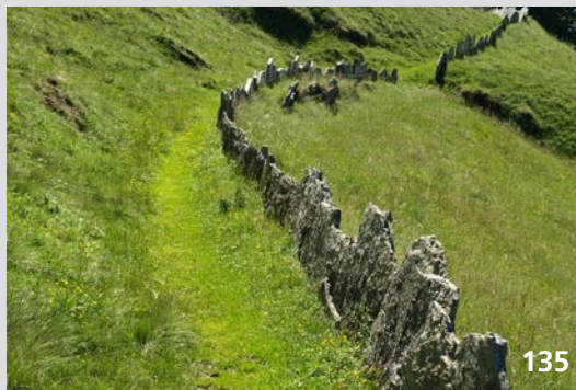
Recinzione in pietra calcarea sugli alpi del Monte Generoso (TI).
