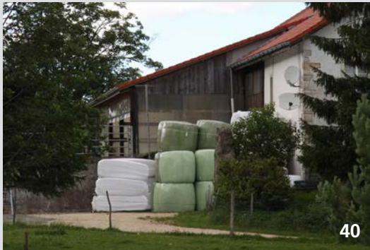
Diskret beim Gebäude gelagerte Siloballen (Freiberge, JU).
