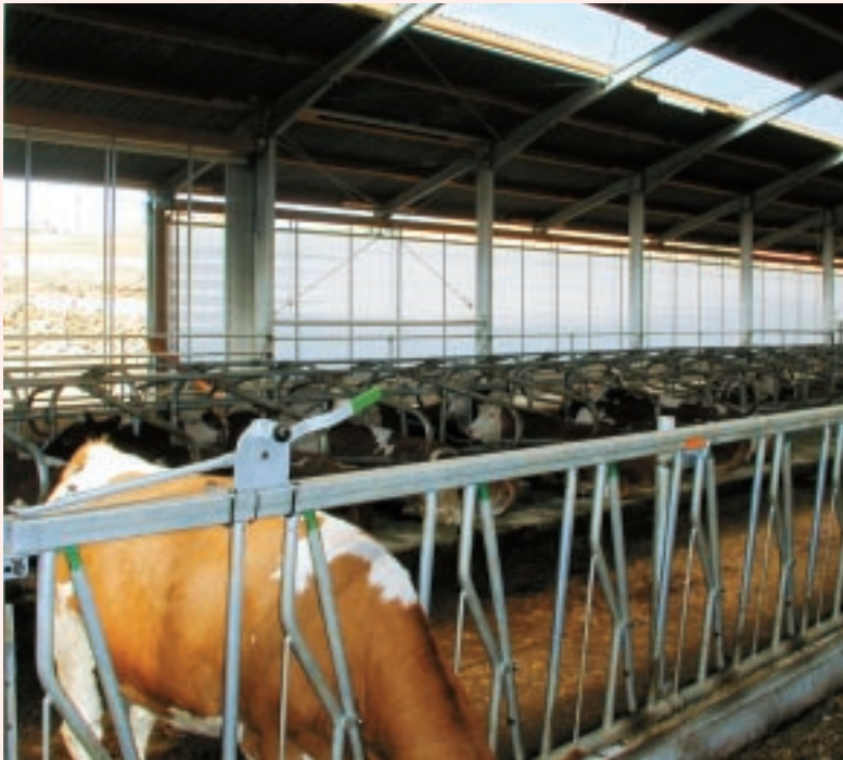
Les étables hautes et ouvertes, disposant de protections contre le vent sur les parois latérales, sont plus fraîches, donc engendrent moins d'émissions.
